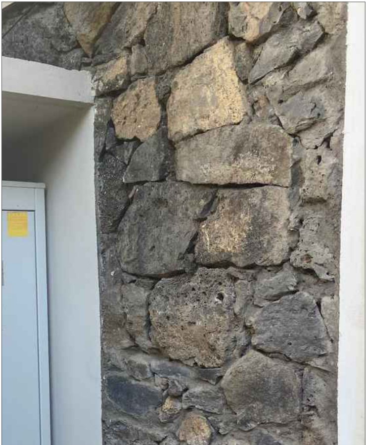
PHOTO DU SOUBASSEMENT EN MOELLON A REPRODUIRE POUR LE MUR DE DOUBLAGE AGRAFE
